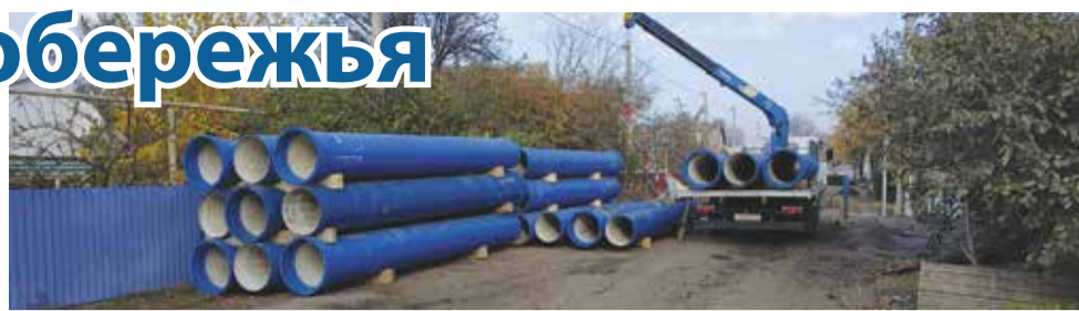
Город Гуково Ростовской области. Подготовка к прокладке водовода из ВЧШГ-труб методом горизонтально направленного бурения (бестраншейным методом)
