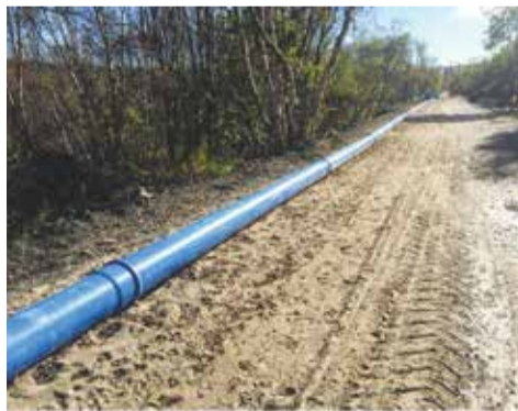
Смонтированная плеть трубопровода ПВХ-О 500 MOLECOOL
