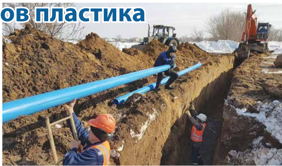
Монтаж трубопровода ПВХ-О 500 MOLECOOL в условиях низкой температуры
